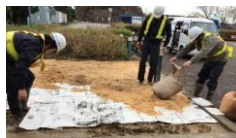
植込み撤去と雑草ガード敷き込み
